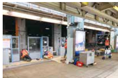
東鐵線馬場站開始安裝幕門。
