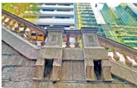
石階扶手下配以托斯卡納式欄杆柱。
