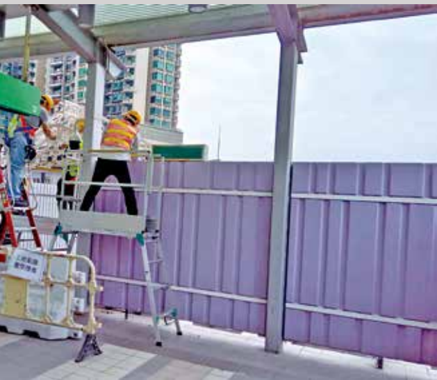
工人在封閉通道後，拆除臨時通道支架。
