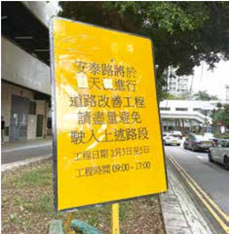
工程人員為安邦路重鋪路面。
