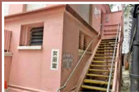
女浴室位於上層，以戶外樓梯連接。
