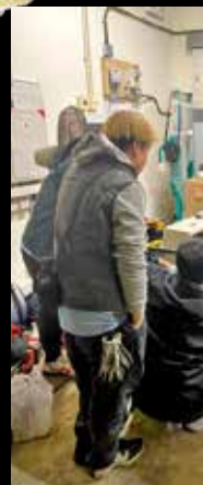
機電署事後全面檢查街市電力裝置。
