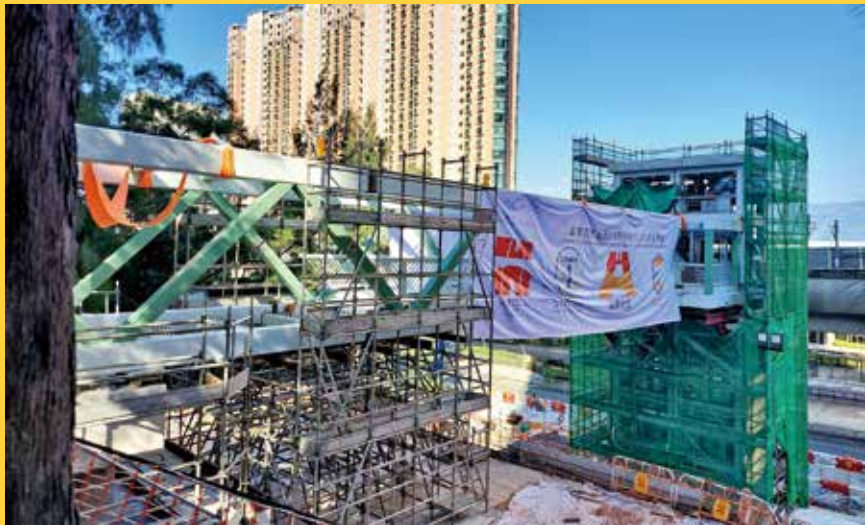
滲水山坡附近正為建轉塔施工。
