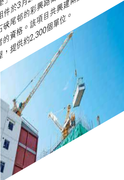
彩興路簡約公屋已完成所有組件吊裝。
