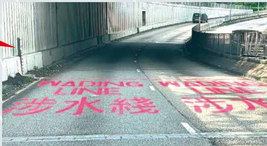
大埔南運路新增涉水線及水位標尺。
