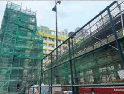
路政署正在大隴街進行升降機系統工程。（資料圖片）
