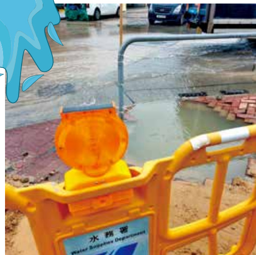
三聖街鹹水食水管同爆裂，情況罕見。
