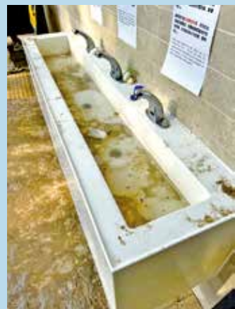
營地附近的洗手盆，疑被食物殘渣及泥沙堵塞。
