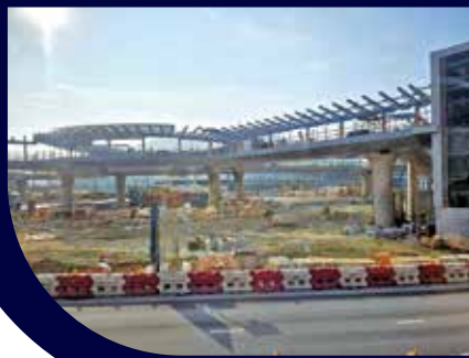
龍躍頭圓環行人天橋，採用國產超高強度鋼材建造。
