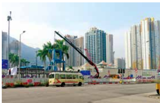
舊泳池已關閉並將拆卸，以配合興建第16區新車站。
