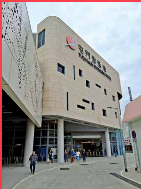
位於龍富路的新屯門游泳池2月24日啓用。
