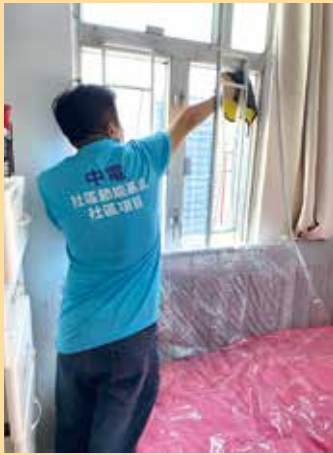
中電技術人員為住所窗戶安裝高透光隔熱貼。
