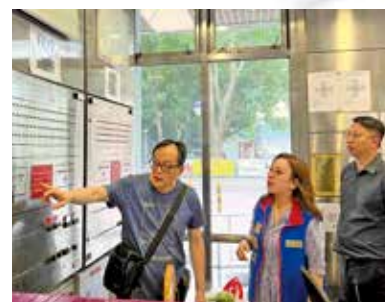
賴嘉汶促開展全邨消防系統全面檢查。
