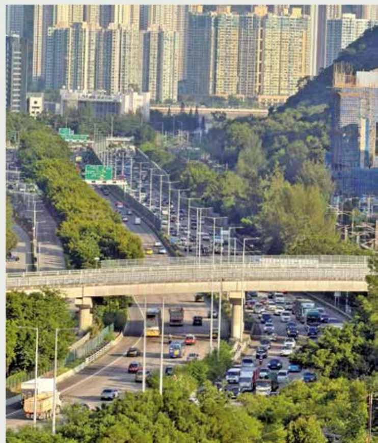
吐露港公路繁忙時間車流量飽和超出設計。
