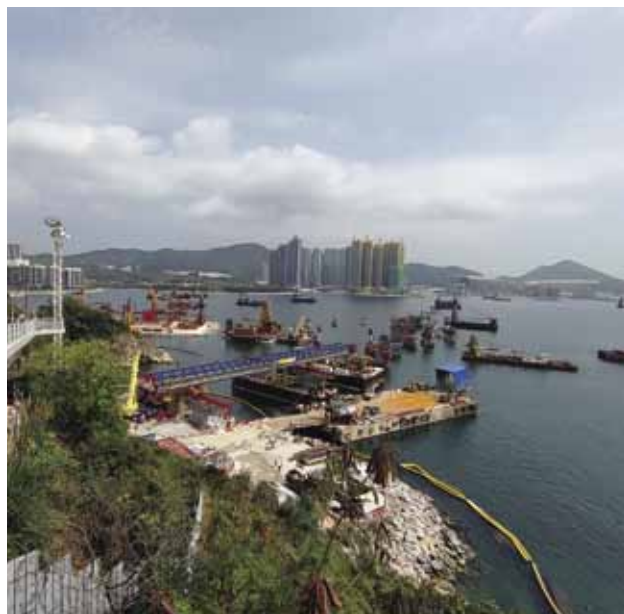
將藍隧道填海施工，白石柱灘漸漸淹沒。
