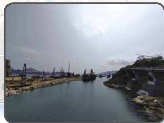
隧道出口一帶已完成填海，正建大橋及橋臺。
