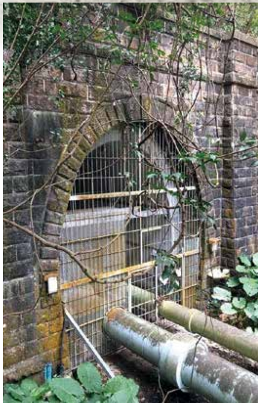
畢架山隧道於 1984 年由火車隧道改變成煤氣管道。
