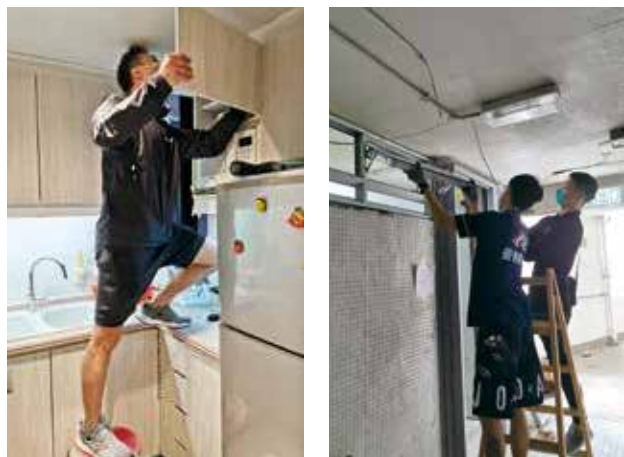
替街坊家居「整色整水」。為將軍澳區內屋苑維修施工。
