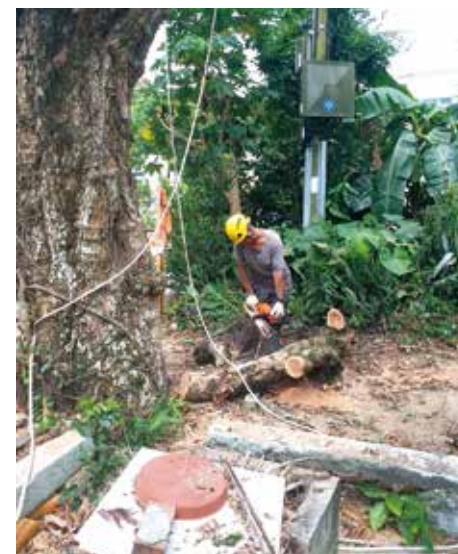
黃漁灘村外有移除枯樹工程。
