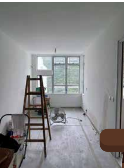
第四及第五座住戶正如火如荼進行裝修。
