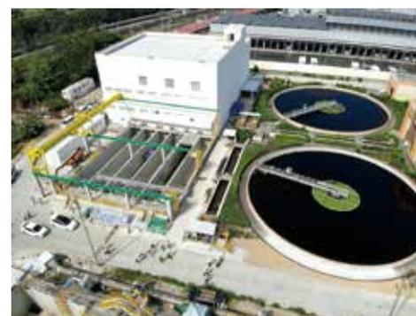
石湖墟濾水廠正擴建，為施工中的薄膜生物反應系統大樓。
