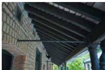
由木製或鐵製桁架支撐的雙層中式金字瓦頂。
