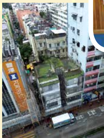
不少逾 50 年樓齡樓老化失修。
