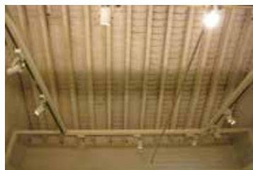
由木製或鐵製桁架支撐的雙層中式金字瓦頂。
