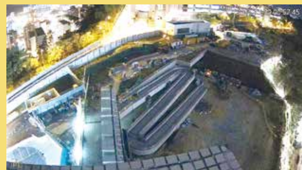
為興建新大樓，舊有公園正拆卸。
