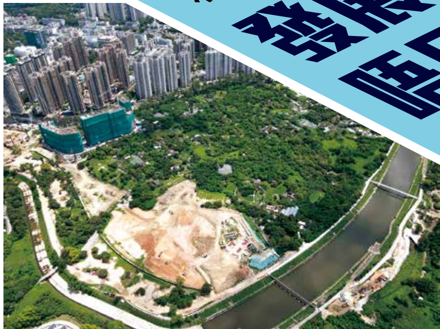
粉嶺北第 15 區東首階段公營房地盤正在平整。
