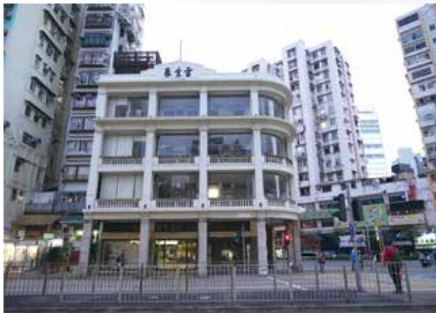
雷生春正面外牆為水磨石以及紅磚身外加灰泥批盪。
