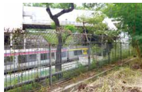
隧道旁是現行筆架山鐵路隧道。
