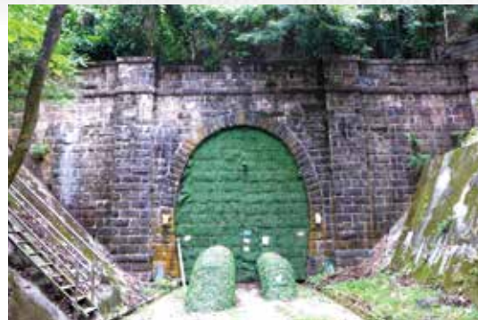
煙墩山隧道九龍出口近年加上人工草皮。
