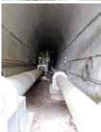
火車改道後，煙墩山隧道成為煤氣及天然氣輸送管道。
